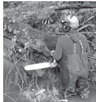
Likvidace následků povodní v korytě Zborovského potoka.
