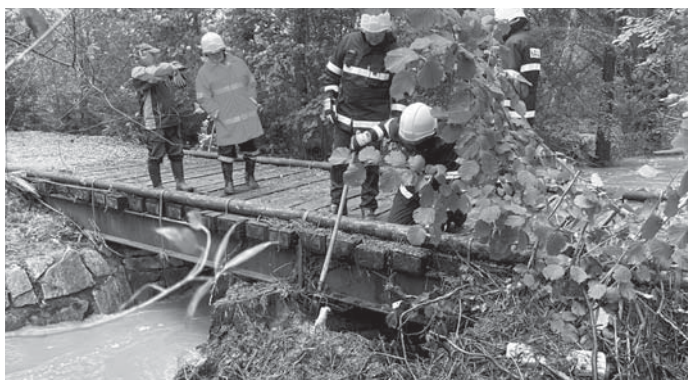
Odstraňování zaklíněného pařezu pod mostem v chatové oblasti Borovnice
