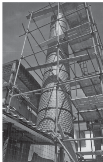
Oprava komína kolem roku 2000.
