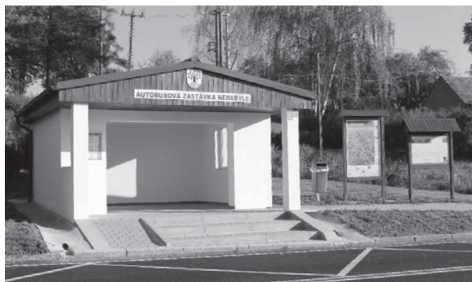
Čekárna po rekonstrukci.
