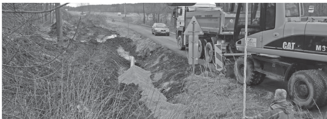
Výkopové práce za odbočkou z hlavní silnice na starou část Nové Vsi.
