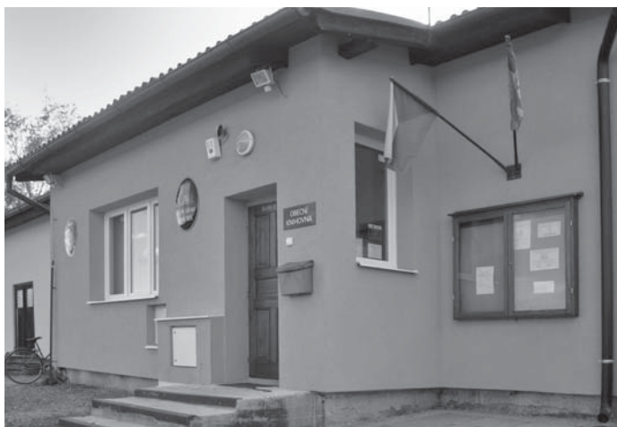
Takto vypadal vchod do OÚ před rekonstrukcí (foto z roku 2008).
