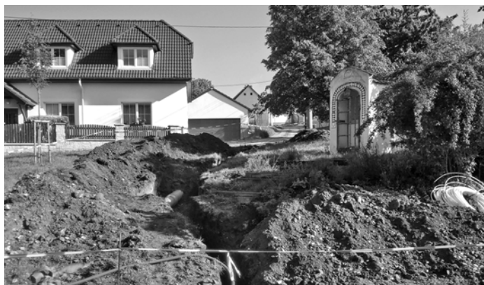
Výkopy na Hůrce těsně před položením elektrické kabeláže.
