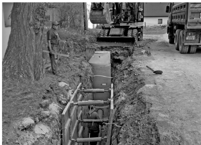
Kanalizační výkop dosahuje v určitých úsecích značné hloubky.
